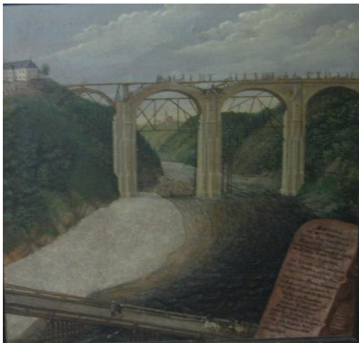
Abbildung 3: Bau der Kematner Hochbrücke
